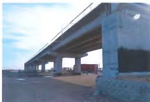
Fig. 6.7.4-1 Aspecte generale pasaj km 5+366
