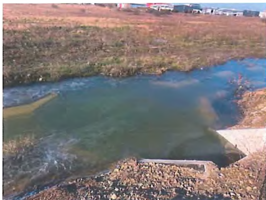
Fig. 6.5.33-28 - Capăt podeț aval
