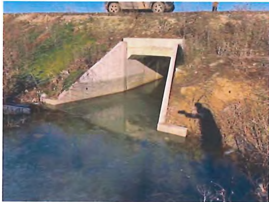
Fig. 6.5.33-17 - Capăt podeț aval
