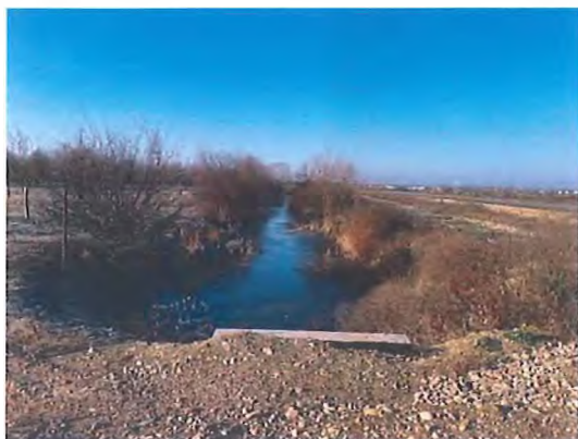
Fig. 6.5.33-12 - Capăt podeț aval
