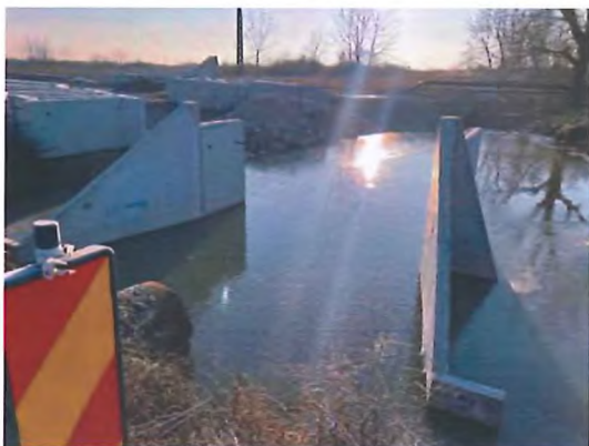
Fig. 6.5.31-2 - Situație demarare lucrări
