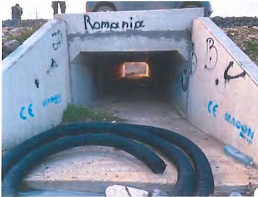
Fig. 6.5.29-4 - Capăt podeț aval
