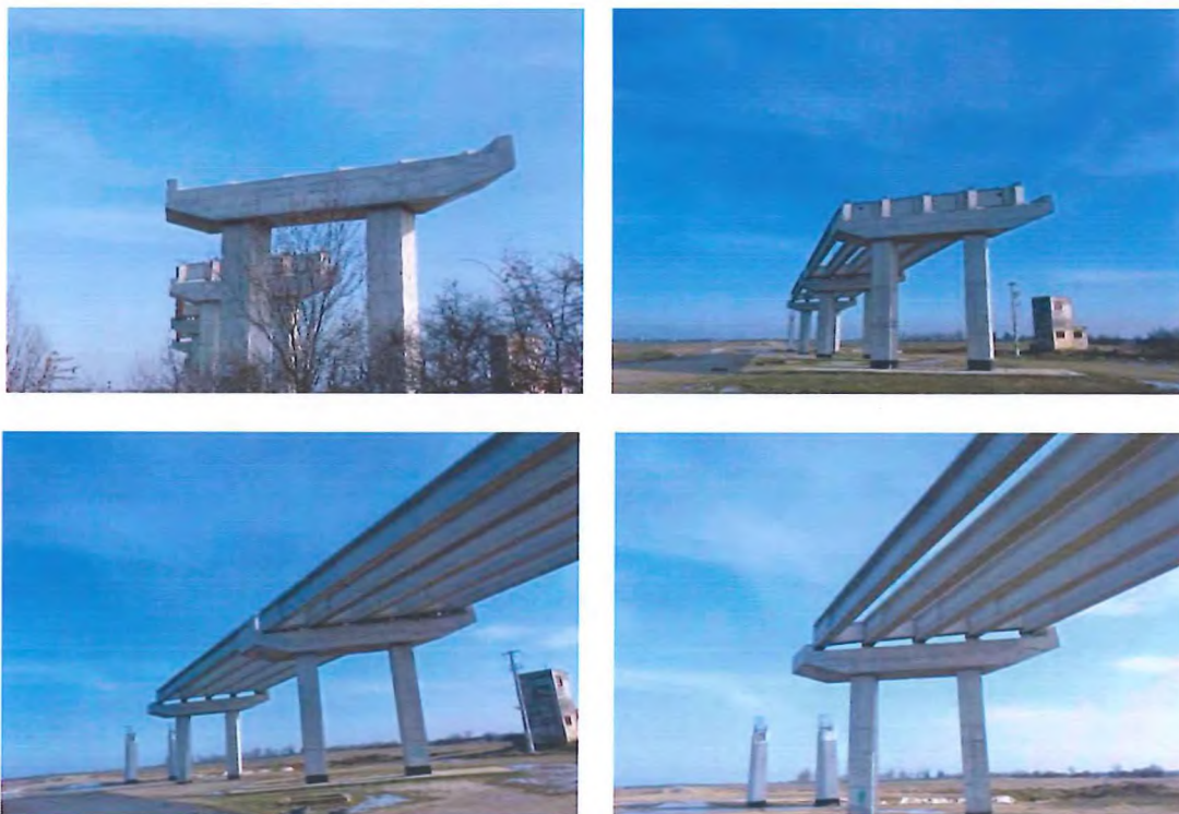
Fig. 6.7.5-2 Situație existentă pile – Grinzii montate pe deschiderile 7-8
