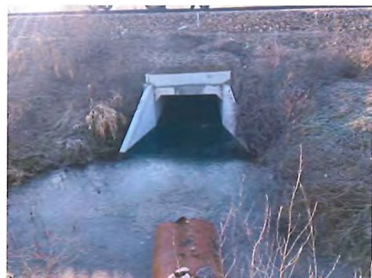
Fig. 6.5.33-8 - Capăt podețe amonte
