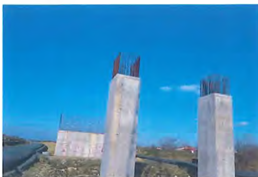
Fig. 6.7.9-1 Vedere de ansamblu stadiu structură km 18+117
