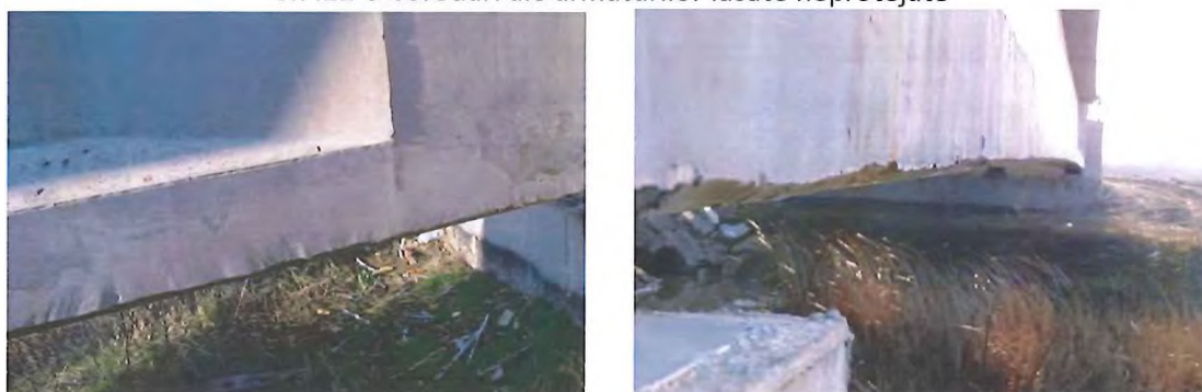
6.7.11-4 Aspecte grinzi/zona cu reparații
