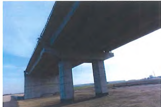
Fig. 6.7.4-7 Vedere intrados deschiderea 4 și pila P4
