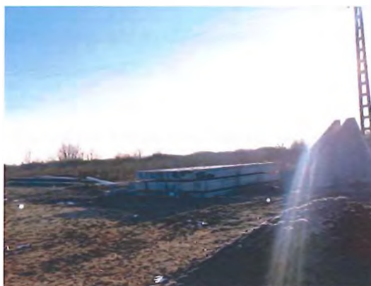
Fig. 6.5.31-4 - Depozitare dale prefabricate prefabricate tip D5
