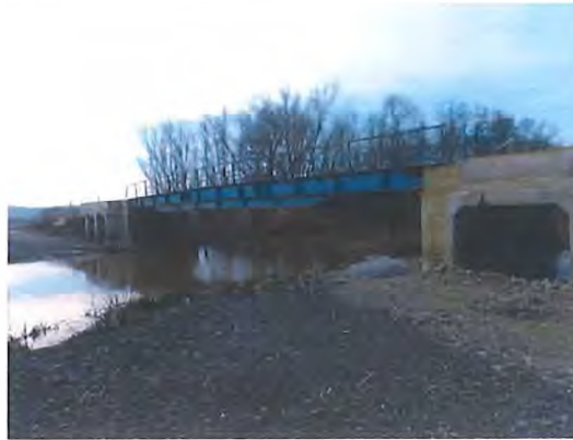
6.7.12-5 Vedere ansamblu pod provizoriu peste Bega
