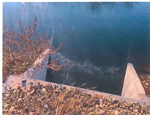
Fig. 6.5.33-5 - Capăt podeț aval
