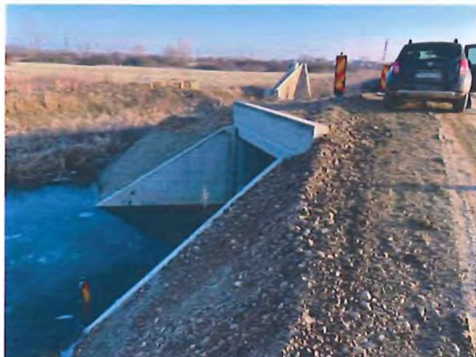
Fig. 6.5.32-2 - Capăt podeț aval
