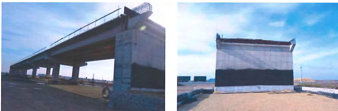
Fig. 6.7.4-2 Aspecte generale pasaj km 5+366
