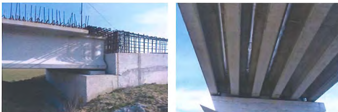
Fig. 6.7.6-3 Vedre laterală și intrados grinzi
