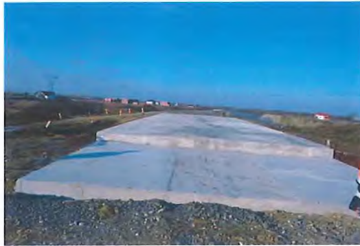
6.7.10-1 Vedere de ansamblu stadiu structură km 18+926
