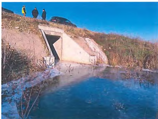
Fig. 6.5.33-20 - Capăt podeț aval
