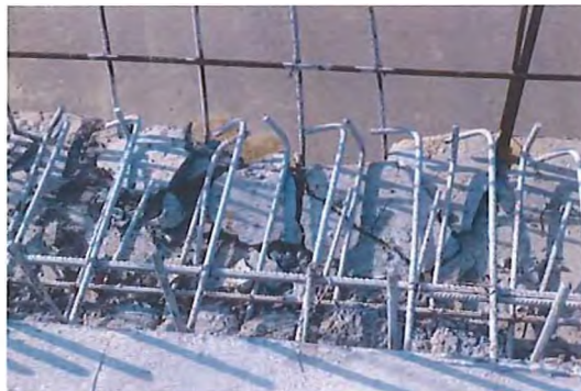
Fig. 6.7.6-7 Placa superioară a grinzii marginale, lovite
