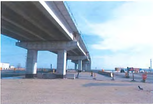
Fig. 6.7.4-6 Vedere intrados deschiderea 2 și pila P2
