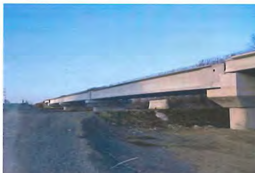
6.7.12-1 Vedere de ansamblu structură km 24+725
