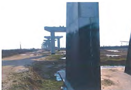
Fig. 6.7.8-1 Vedere de ansamblu stadiu structură km 15+072
