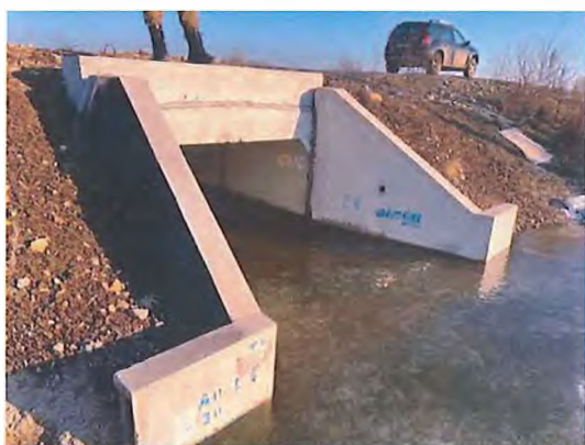
Fig. 6.5.32-6 - Capăt podeț aval
