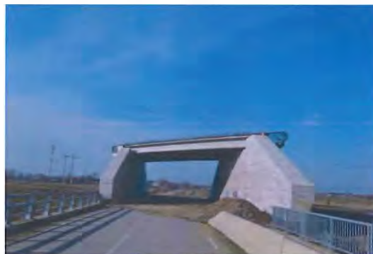
Fig. 6.7.7-1 Vedere de ansamblu structură km 11+576
