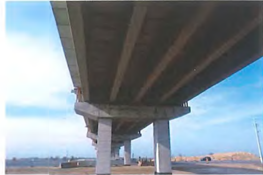
Fig. 6.7.4-5 Vedere intrados deschiderea 1 și pila P1
