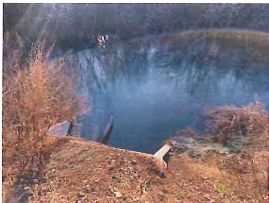
Fig. 6.5.33-7 - Capăt podeț aval
