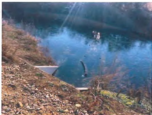
Fig. 6.5.33-10 - Capăt podeț aval
