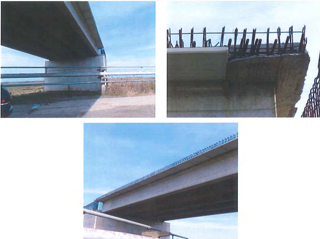
Fig. 6.7.3-3 Aspecte generale suprastructura pasaj
