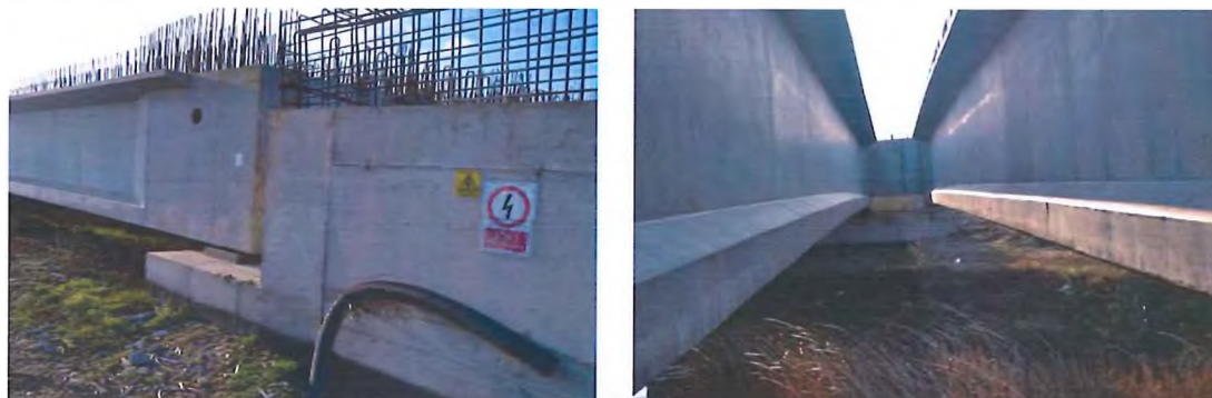
6.7.11-2 Aspecte grinzi montate
