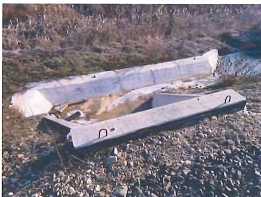
Fig. 6.5.33-23 - Capăt podeț aval
