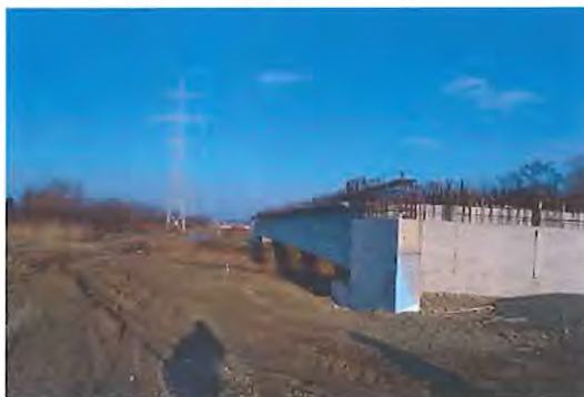
6.7.11-1 Vedere de ansamblu stadiu structură km 20+875
