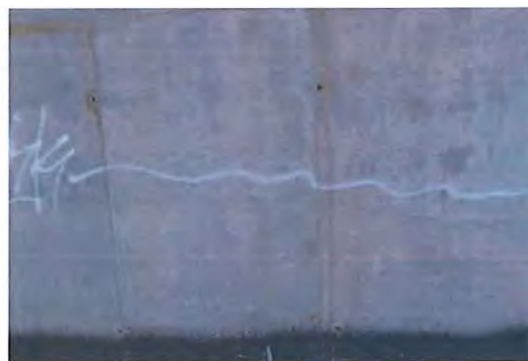
Fig. 6.7.7-3 Fisuri verticale
