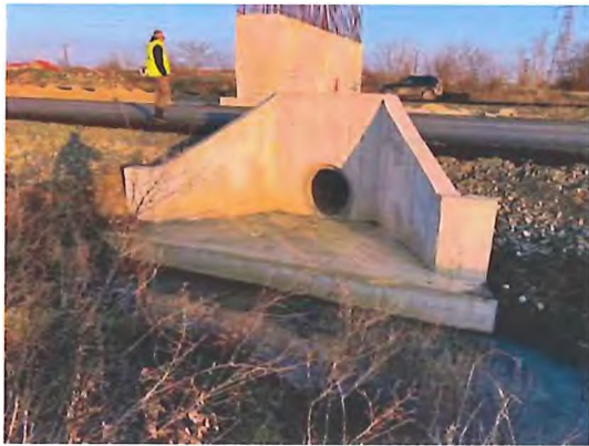
Fig. 6.5.29-2 - Capăt podeț aval
