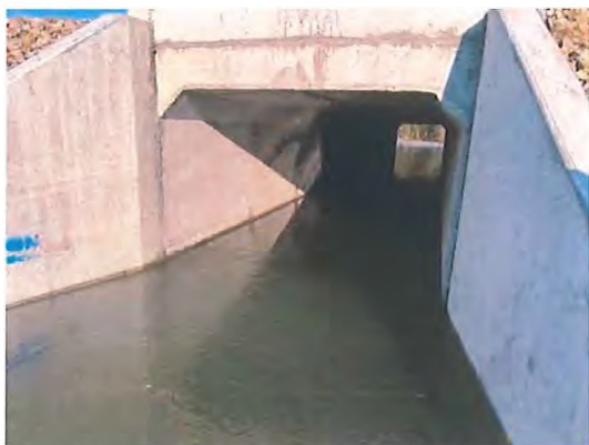
Fig. 6.5.33-15 - Capăt podeț aval
