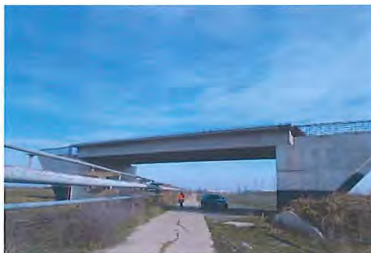
Fig. 6.7.3-1 Aspecte general structura km 3+509
