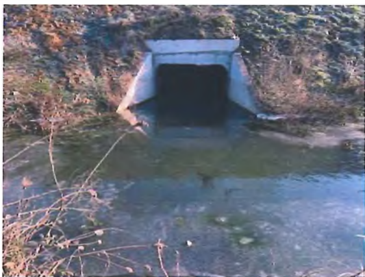
Fig. 6.5.33-26 - Capăt podeț aval
