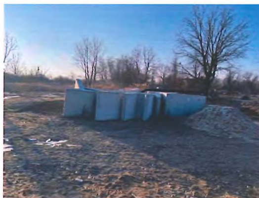
Fig. 6.5.31-3 - Depozitare elemente prefabricate tip L3
